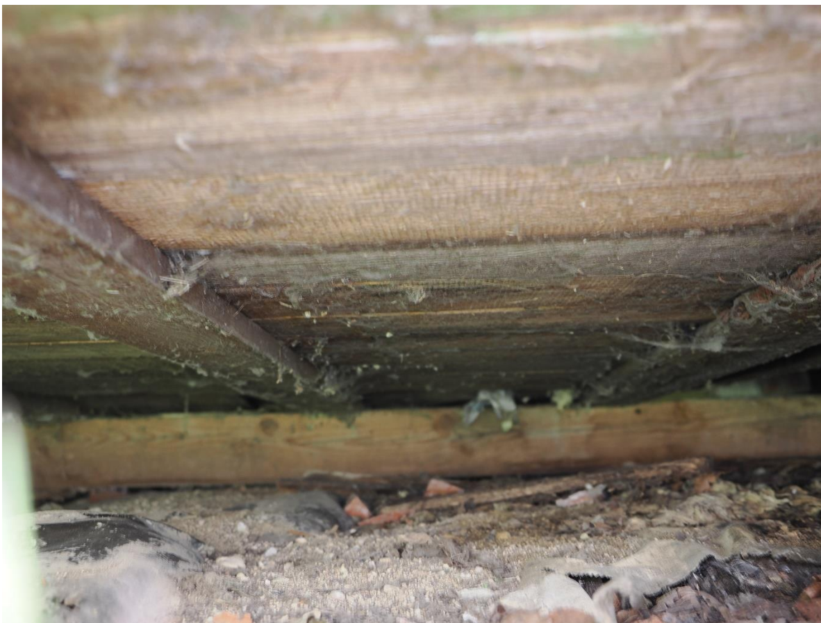
Foto 16. Kahjustatud põrandataala idapoolses küljes saunaosa all.
