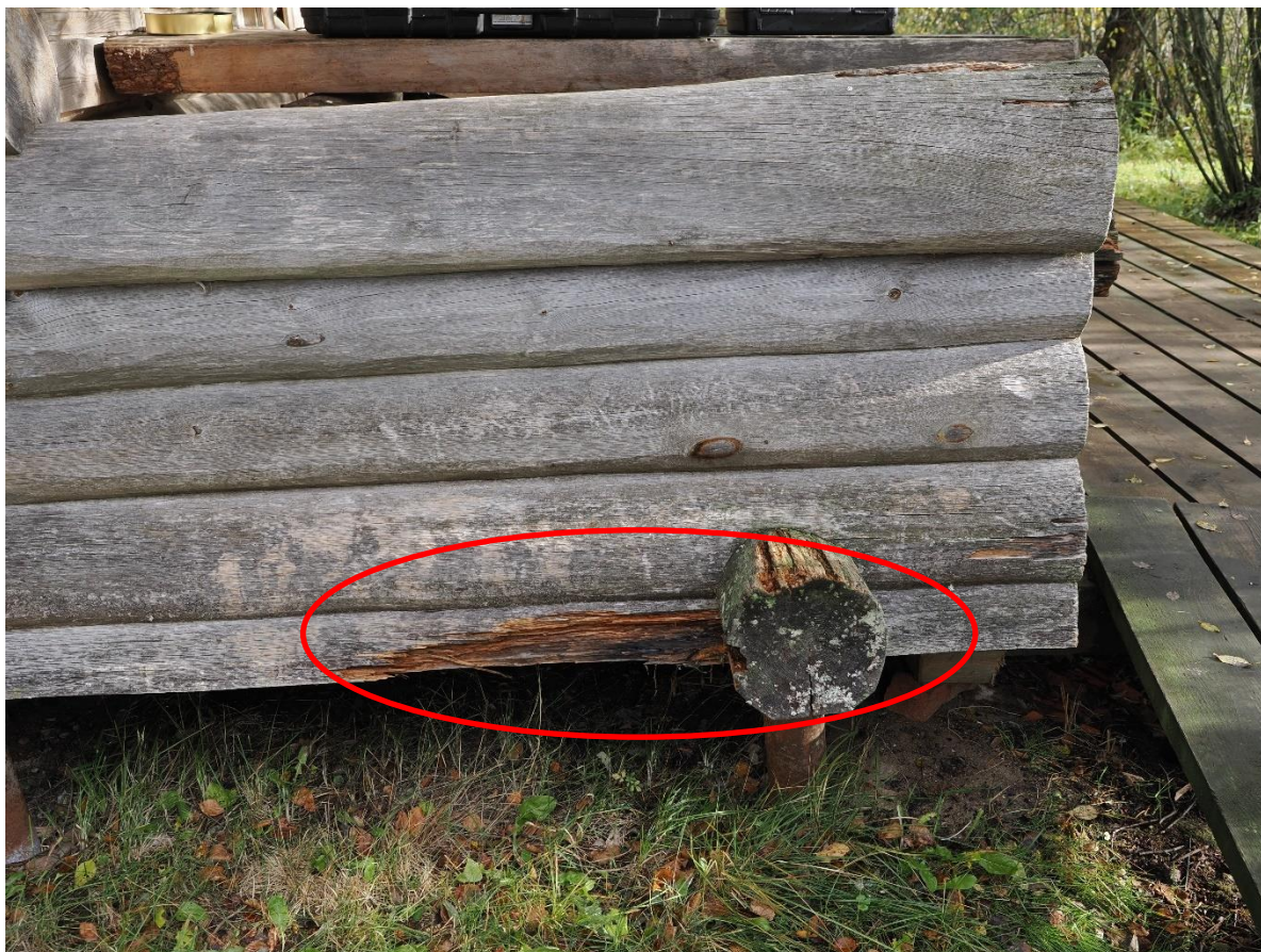
Foto 12. Edelanurga kahjustatud alumised palgid.
