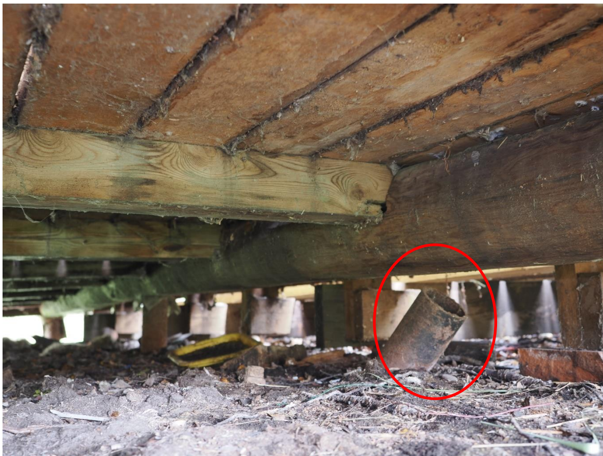
Foto 24. Deformeerunud post terrassi aluskonstruktsioonis.
