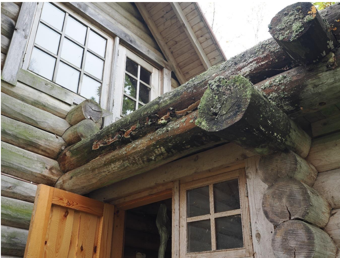
Foto 4. Tugev seenkahjustus põhjapoolse külje ülemistel palkidel. Proovi P1 võtukoht.
