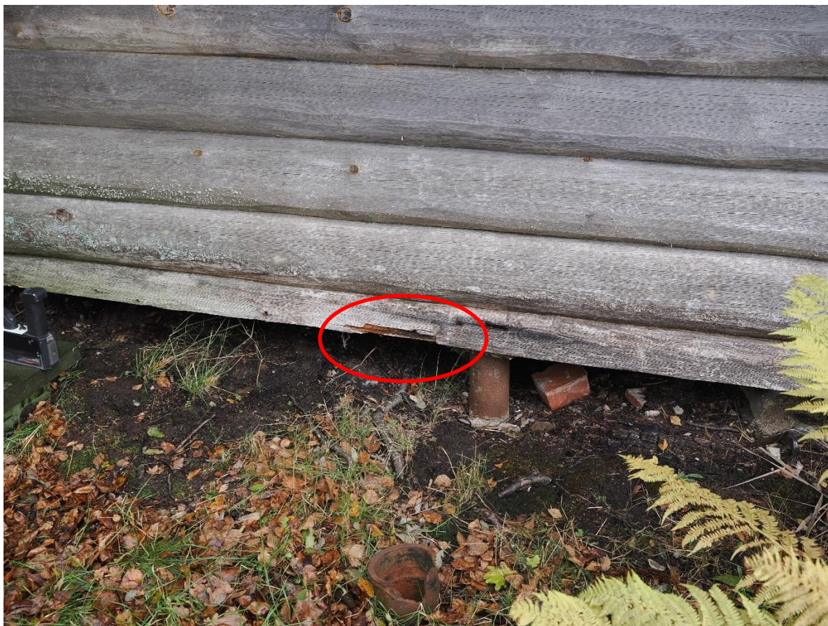
Foto 11. Läänepoolse palkseina alumise palgi kahjustused.
