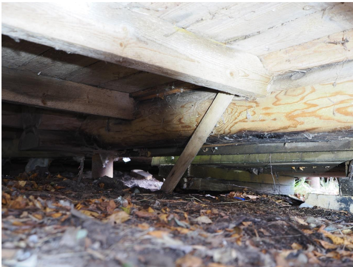
Foto 25. Tugeva kahjustusega põrandataala juurdeehituse ukse piirkonnas.
