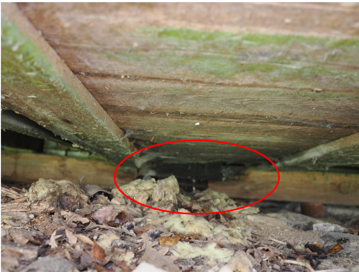
Foto 17. Tugeva kahjustusega avariiõhtlik põrandatala idapoolses küljes sauna all.
