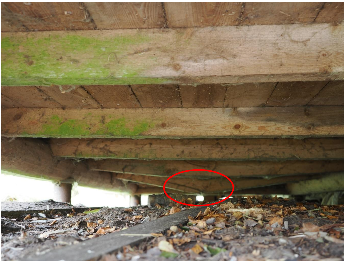
Foto 18. Purunenud põrandatala juurdeehituse (panipaiga) põranda all.
