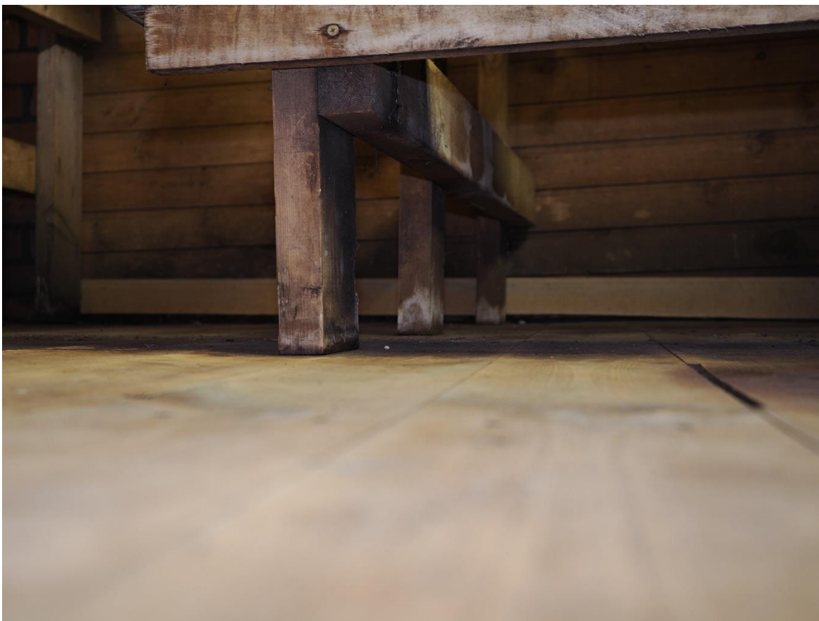
Foto 20. Kahjustatud lava tugipostid ja asendatud põrandakonstruktsioon saunas.
